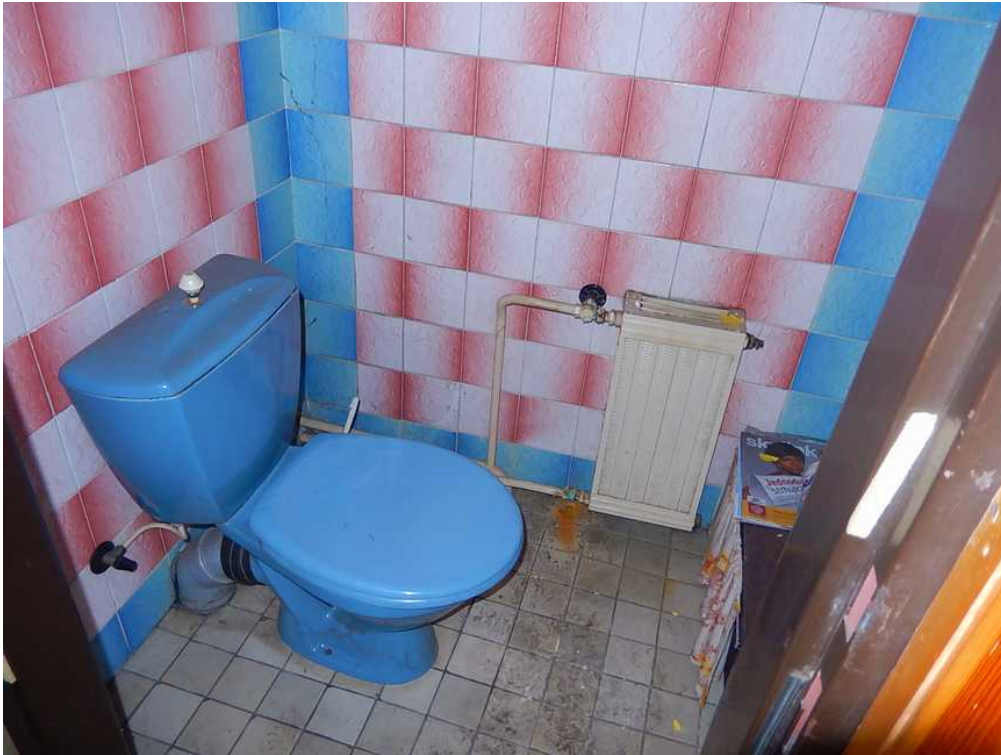
záchod v bytě ve 2.NP
