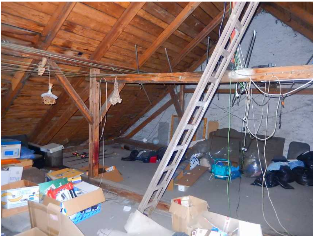
krov nad uliční částí
