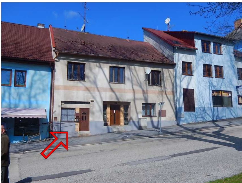
uliční pohled na RD č.p. 55
