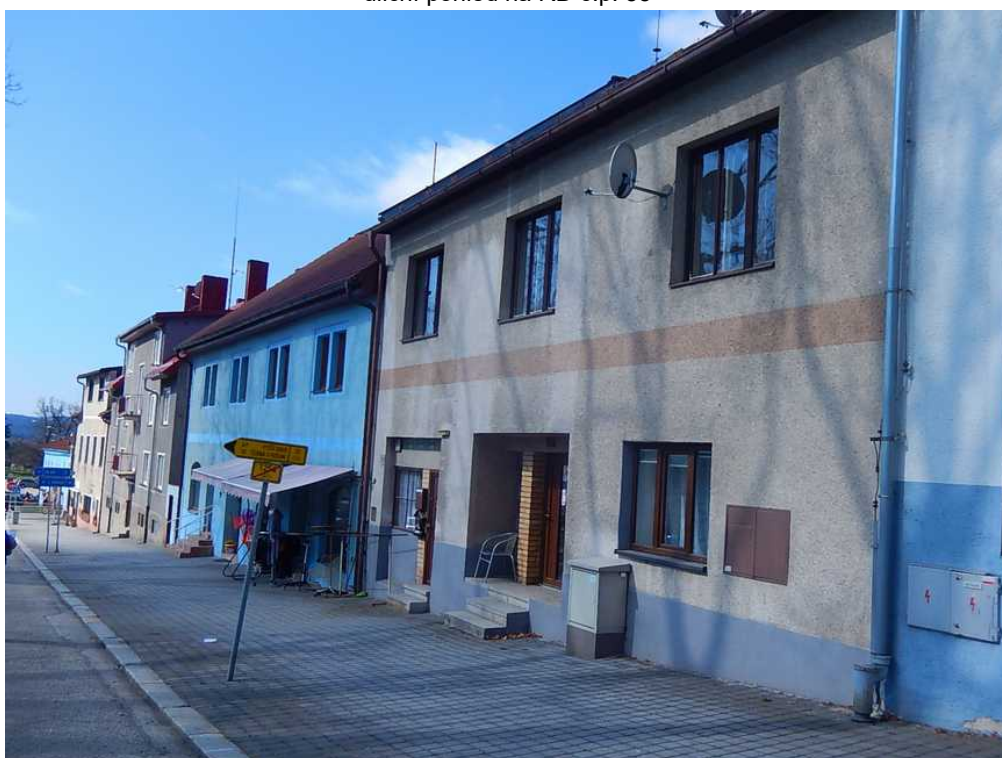
uliční pohled na RD č.p. 55
